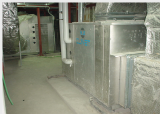
Warner Village Metropolitan – Vista unità Clivet disposta in vano tecnico e unità CSNX-H di Clivet.
