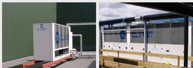
TINE BA – Refrigeratore dedicato agli uffici e refrigeratore per le aree produttive
